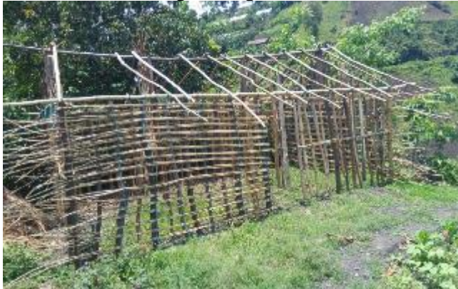
Photo 7 : Une cabane en cours de construction par le PA à Kalungu dans le Sud Kivu Sources E. TOKOROKOU et N. TRESOR Septembre 2018
