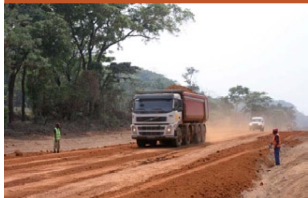
TFM a financé la réhabilitation de 174 km de tronçons de la route nationale entre Likasi et Fungurume.
