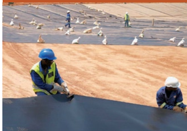
TFM a investi 50 millions de dollars pour l'aménagement d'un bassin de rejet avec revêtement en caoutchouc. C'est le premier bassin de ce genre en Afrique.
