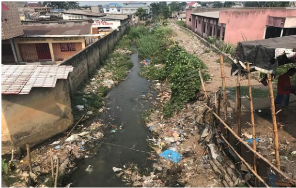
Pollution du cours d'eau par les déchets solides
