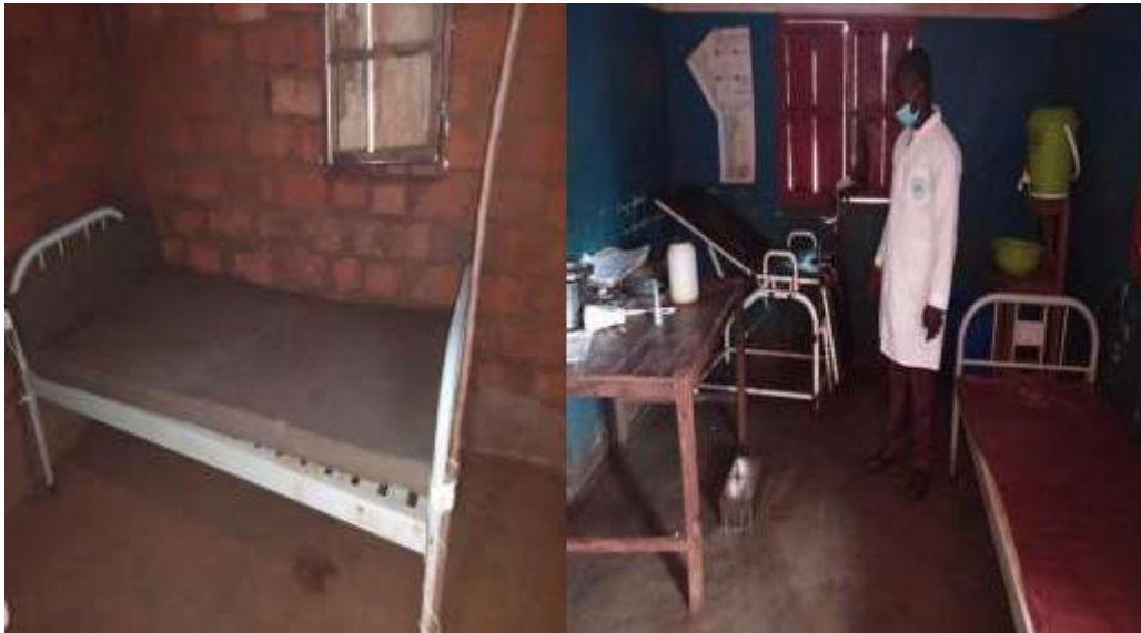
Photo n° 4 : Photo Etat précaire de salle de soin à gauche Luambo à droite kalambambuji
