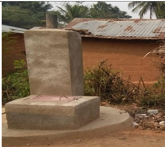
Photo 5 : Fosse à placenta pour la gestion liquide biologique au Centre de Santé APOLO à Kananga
