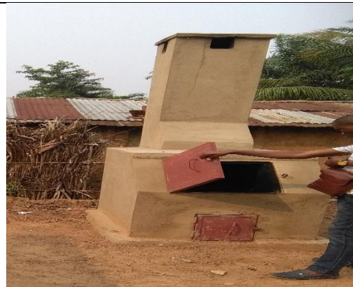
Phot 4 : un incinérateur pour la gestion des déchets au centre de Santé APOLO à Kananga
