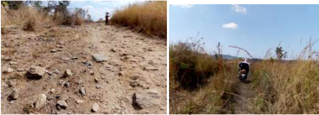
Photos n° 1 et 2 : État de la route
