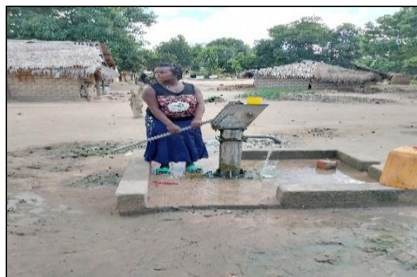
Figure 18: Forage à pompe manuelle
