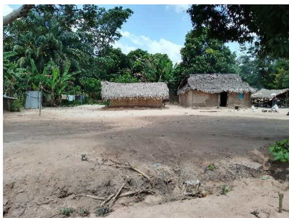
Figure 24 : Point favorable du château d'eau CE2
